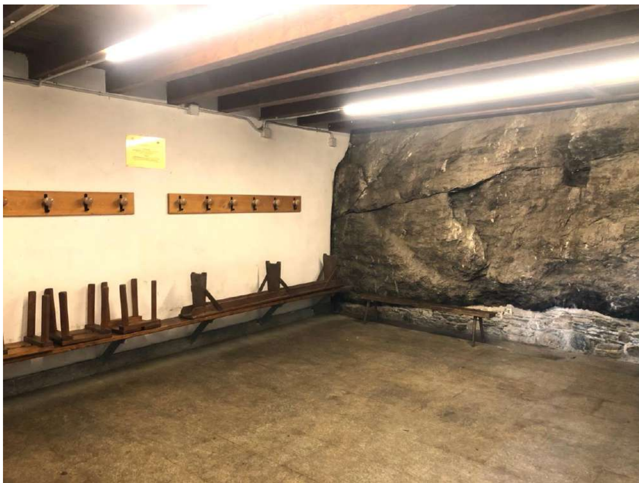
Stanza del camino (piano terreno del Baitone)
